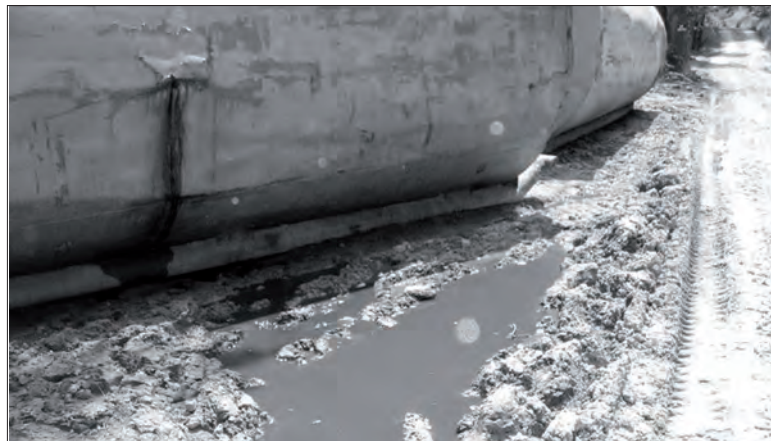
Orificio y fuga en un tanque de almacenamiento de fluido
