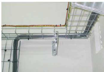
Fig. 1.12. Bandeja perimetral en un RITI.
